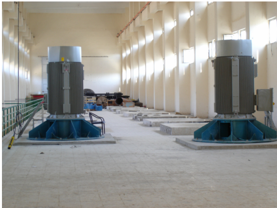
Resim 3. Kuzova Pompa İstasyonu motor katı
