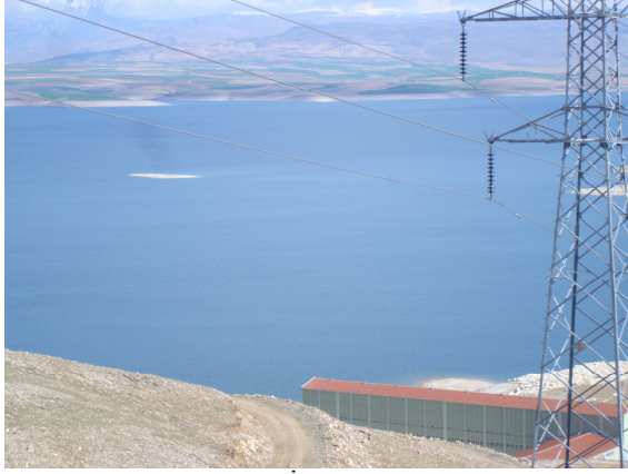
Resim 1. Kuzova Pompa İstasyonu ve Keban Baraj gölü
